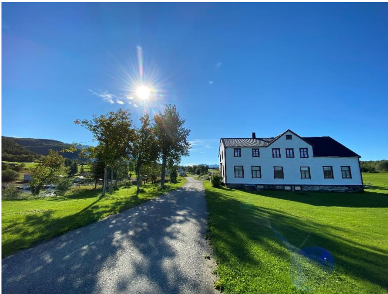
Figur 6: Bilde tatt mot sør. Viser adkomstveien og SEFRAK-registrert bygning.
